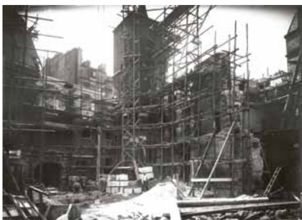
2 Travaux de restauration de la cour de l'Hôtel de Sens. Photo argentique, vers 1930-32 (16,8 x 13 cm)
