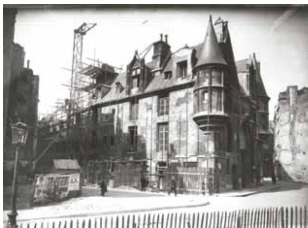
3 Travaux sur la façade de l'Hôtel de Sens. Photo argentique, vers 1930-32 (17 x 12,7 cm)
